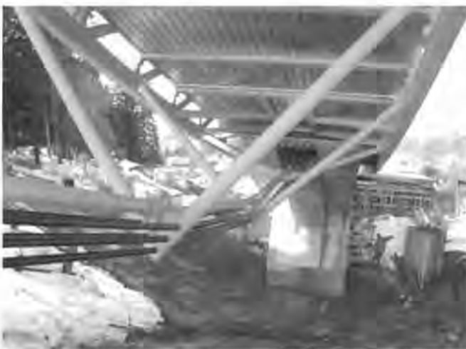
Bild 12. Distanzdreiecke für Seilunterspannung Fig. 12. Distance triangles for cable suspension
