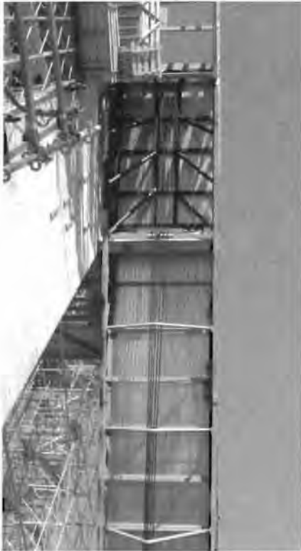
Bild 8. Räumliche Rohrdiagonalen in den Auflagerbereichen zur Lastverteilung Fig. 8. Space diagonals within the support areas of load distribution
