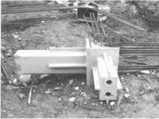
Bild 14. Vorgespannte Andock-Konsolen für den Stahlhut am Turmkopf
