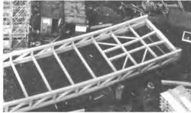
Bild 8. Räumliche Rohrdiagonalen in den Auflagerbereichen zur Lastverteilung Fig. 8. Space diagonals within the support areas of load distribution
