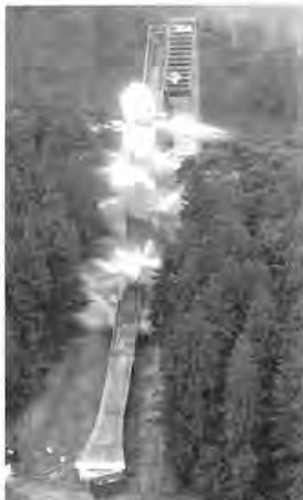
Bild 3. Sprengung der alten Olympiaschanze am 25. März 2001 (Quelle: Krone)
