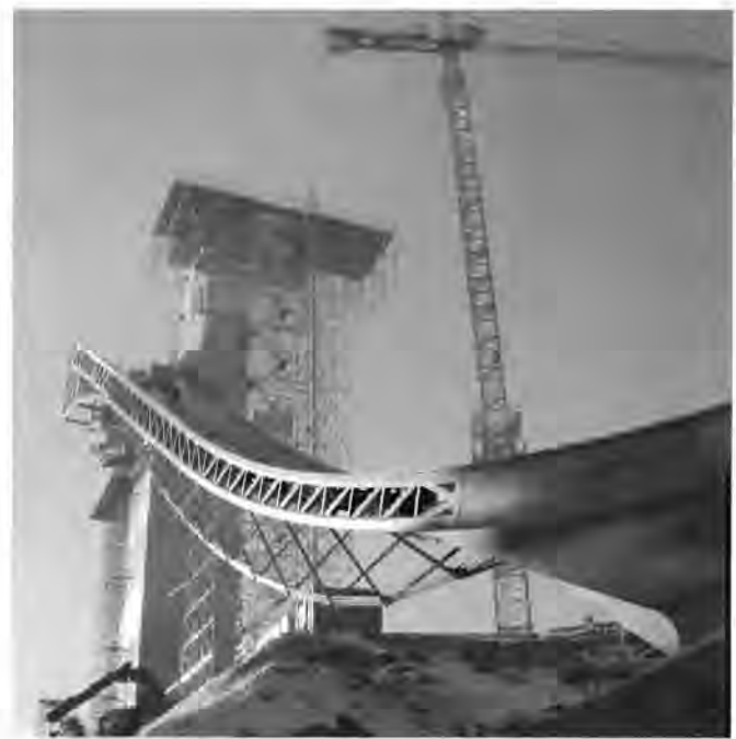
Bild 7. Schanzenturm und freischwebende Anlauftrampe
