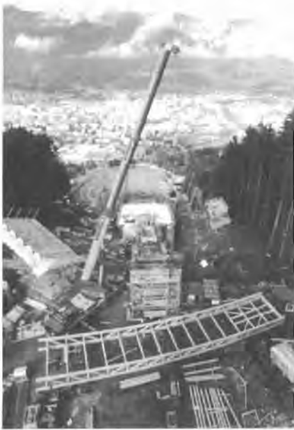
Bild 10. Einheben des ersten Teiles der Anlauframpe Fig. 10. Lifting of the first part of the approach ramp
