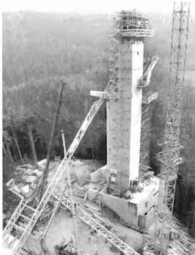
Bild 11. Einheben des zweiten Teiles der Anlauframpe Fig. 11. Lifting of the second part of the approach ramp
