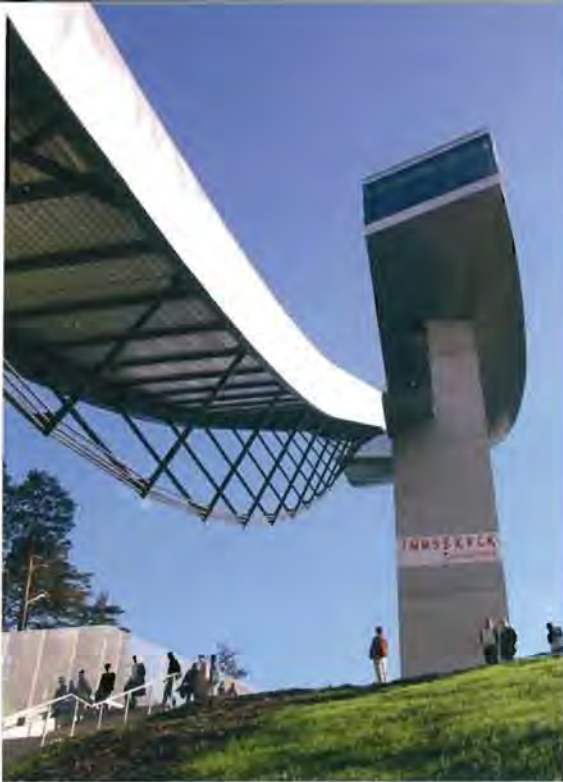
Seilunterstützter Stahlfachwerkträger
