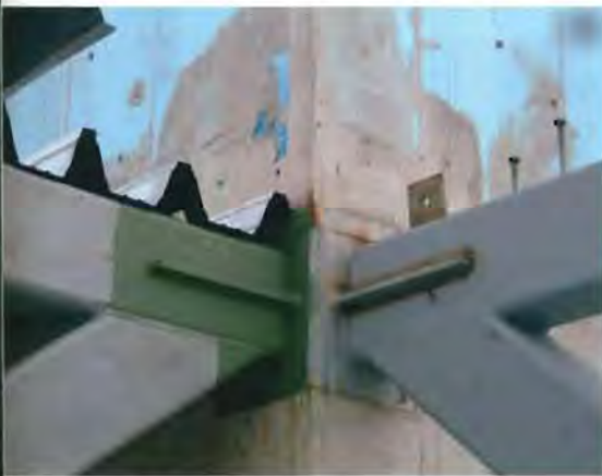
Andockelemente für die Stahlrohrkonstruktion
