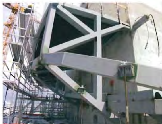
Andocken des Stahlkopfes an den Betonturm
