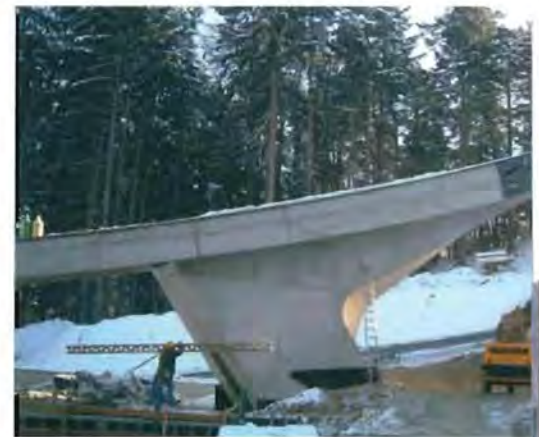
Abprungbauwerk in Form eines Knies
