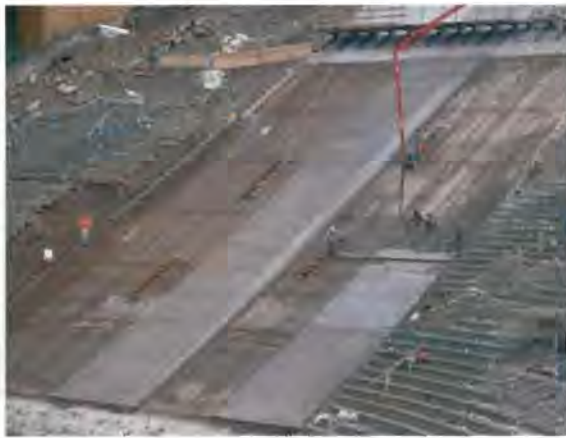
Befestigungsmaßnahmen am Aufsprunghügel Foto: ARGE Bergisel
