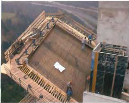
Ausragende, schräge Bodenplatte des sog. Rucksackes
