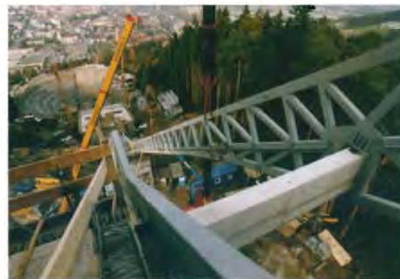
Vorgespannter Konsolenträger zur Lagerung der Anlaufspur
