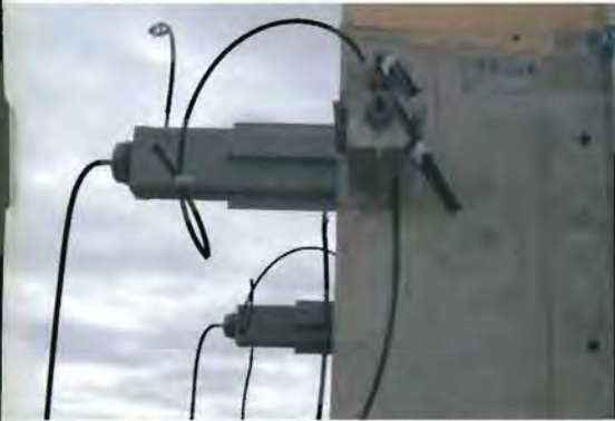
Andockelemente für die Stahlrohrkonstruktion
