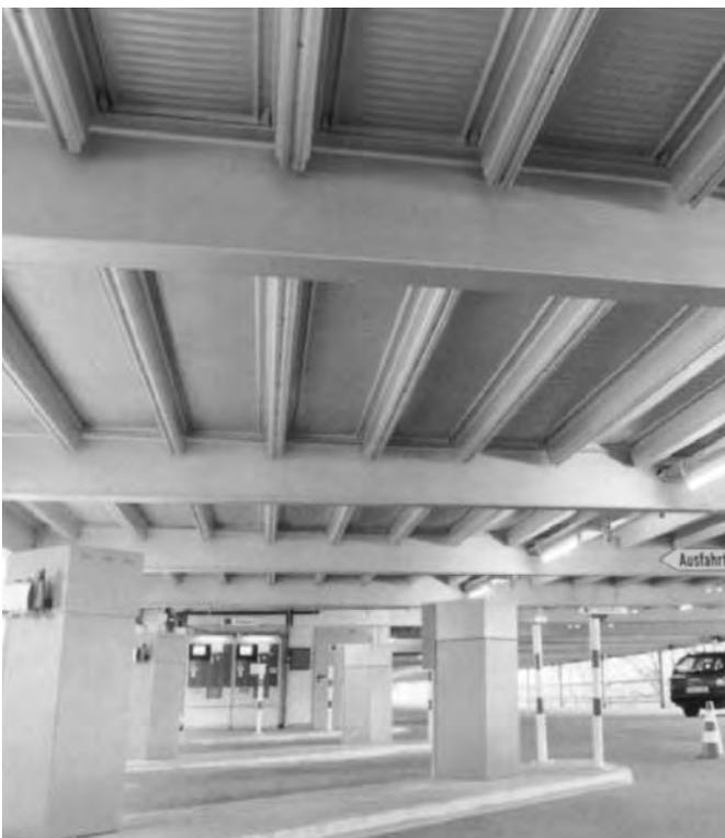
**Bild 5.** Additive Stahlblech-Stahlbeton-Rippendecke – System Hoesch
